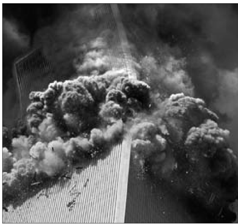
Las explosiones de la demolicion controlada proyectaron los materiales de la fachada y la estructura a decenas de metros
